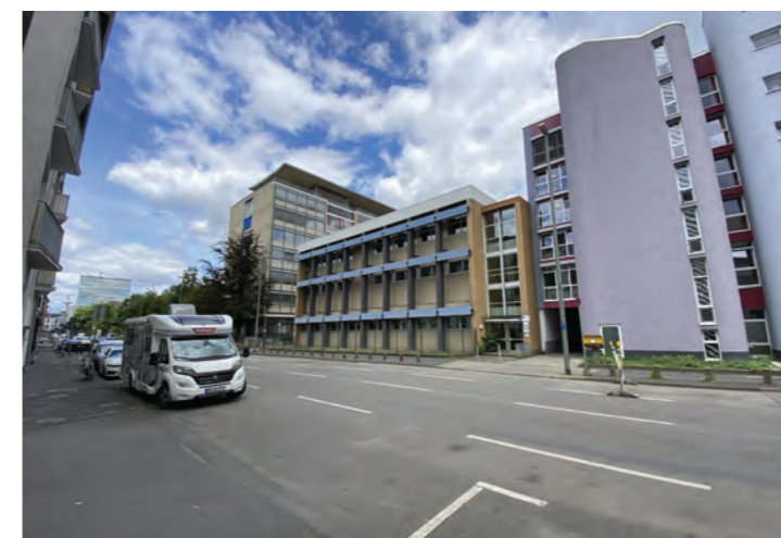
Aufstockungspotential auf der Julius-Leber-Schule
